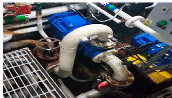
Instalación y Armado del sistema de tuberías Osmosis Inversa BAP. Unión
