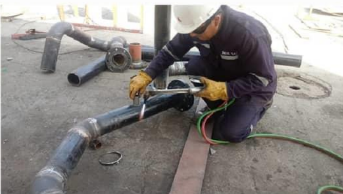
Instalación y Armado del sistema de tuberías Osmosis Inversa BAP. Unión
