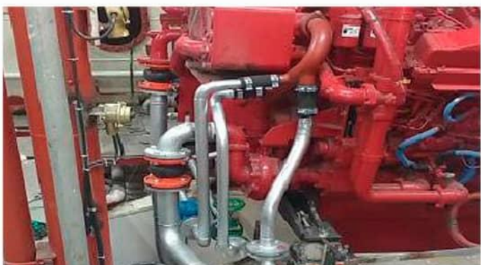
Instalación y Armado del sistema de tuberías Osmosis Inversa BAP. Unión
