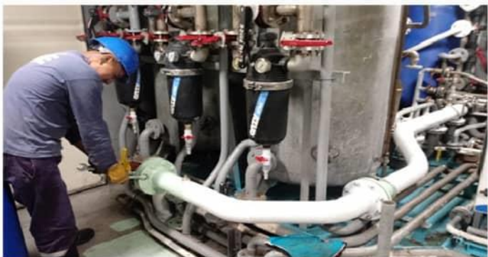
Instalación y Armado del sistema de tuberías Osmosis Inversa BAP. Unión
